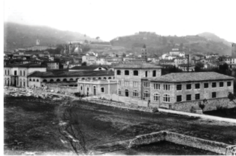
Fig. 9. Fabbrica delle maioliche Matricardi in costruzione accanto al mattatoio pubblico in Campo Parignano (AIPCAP)
